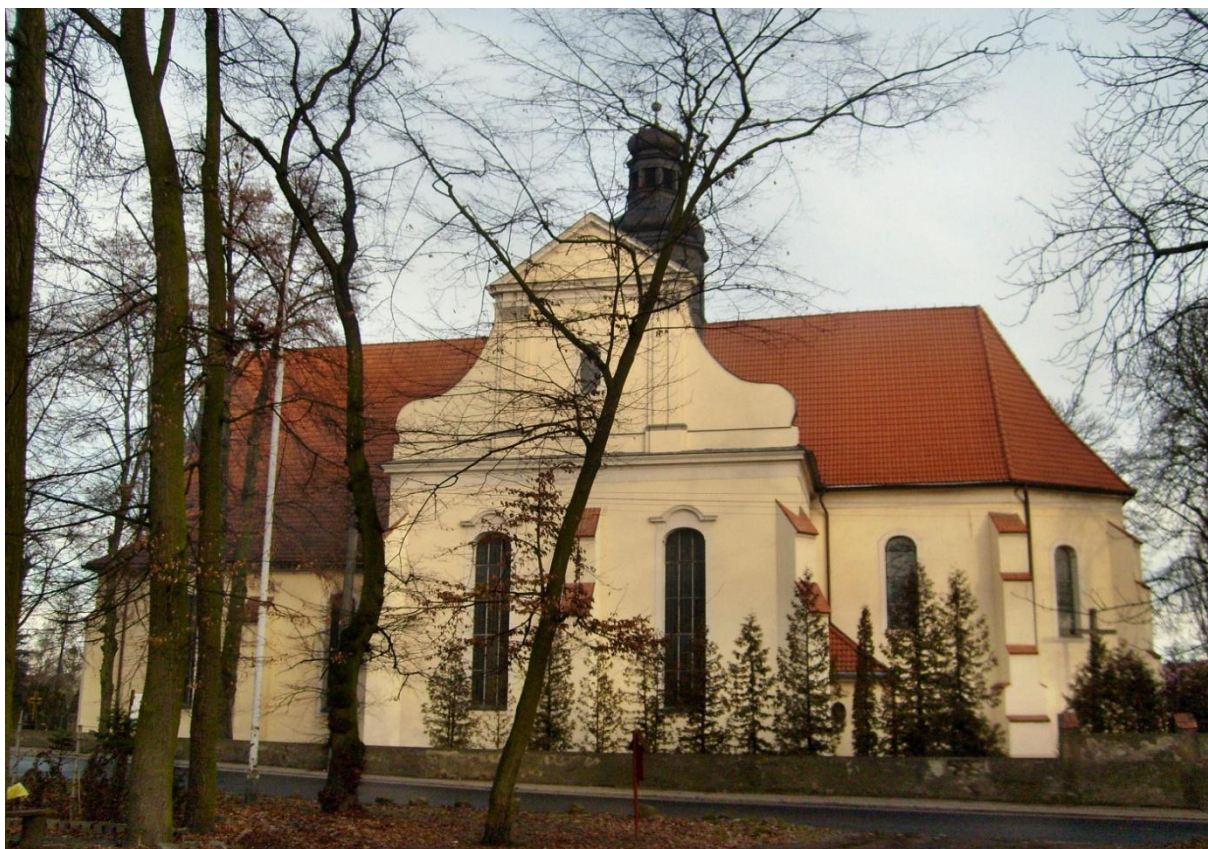
Widok Kościoła od strony południowej
